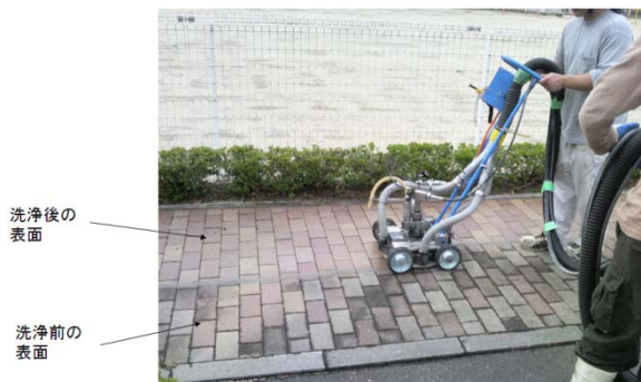
図2 除染の様子(左)とアスファルトを除染して吸引された汚染水
