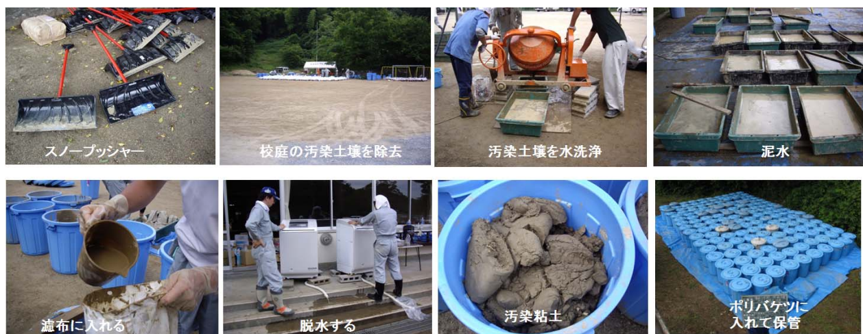
図1 耕野小学校の校庭の除染作業
